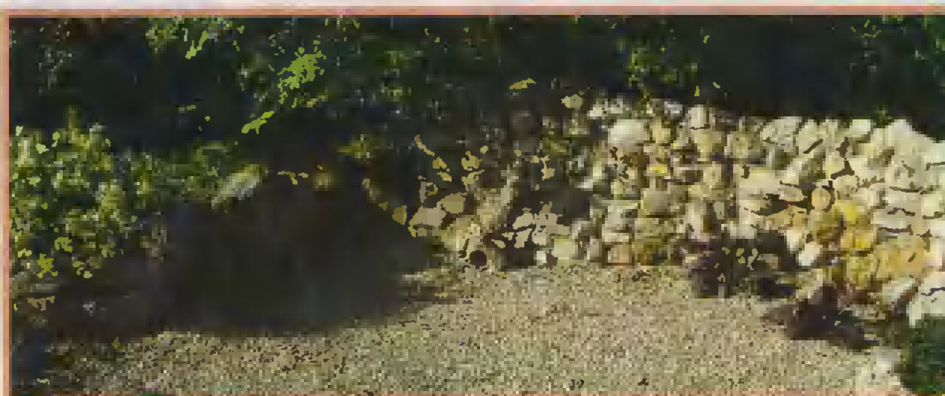
Участок, ограниченный «стеной плача» и порными стенками, отсыпал гравием
