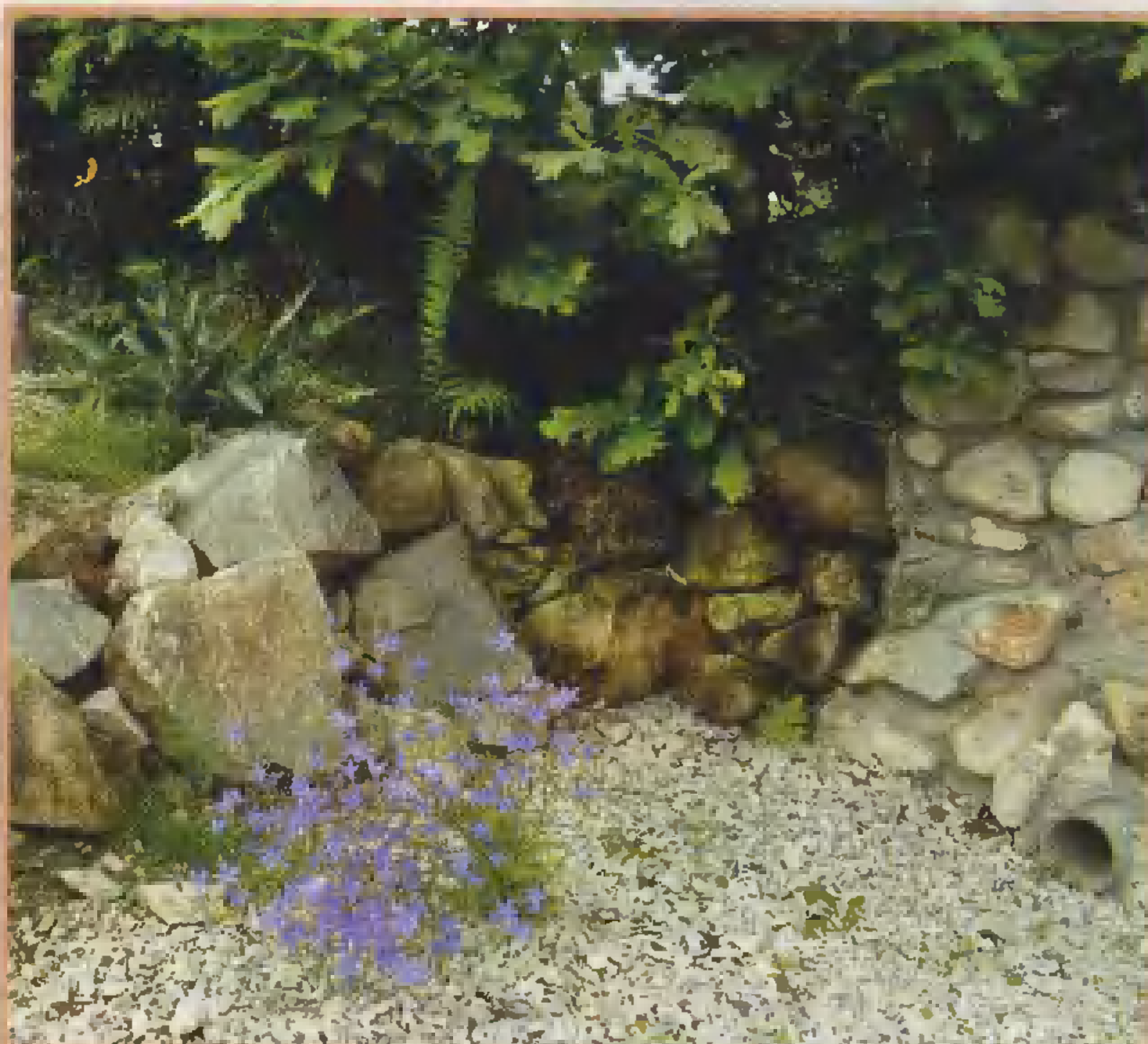
Мелкие камешки, забитые в щели, выравнивают стенку и поддерживают крупные глыбы
